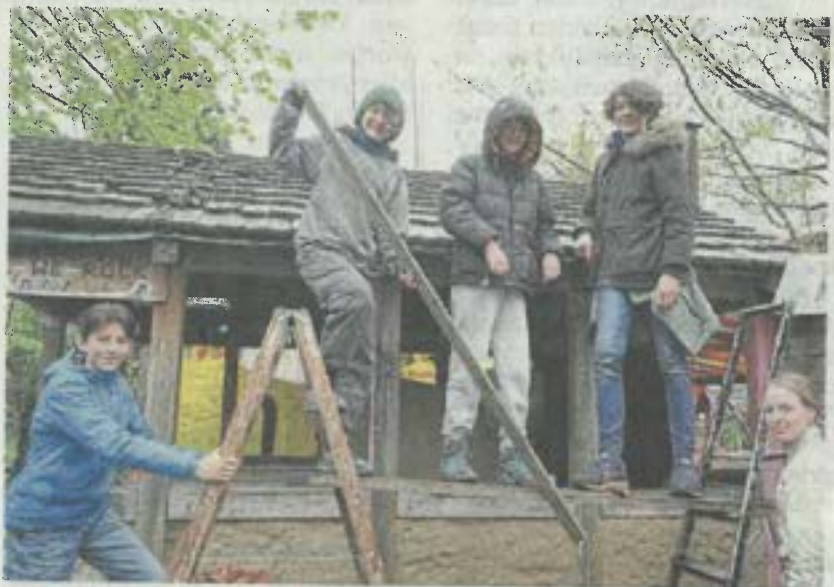
Lorenz (14), Charlotte (14), Michel (12), Emil (13) und Helena (14) erneuern das Dach des Backhauses im Coloradopark. FOTO: ZEGELMANN
